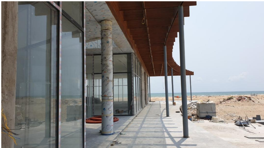
Hình ảnh dự án trong giai đoạn san lấp và thi công Sale Gallery
